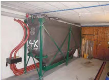
Abb. 10b: Trogsilo mit mehreren Saugentnahmepunkten
